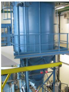
**b baurac Bohrschlamm-Aufbereitungsanlage**
