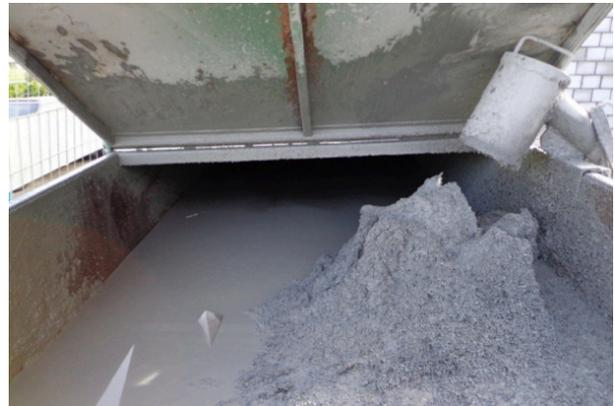
Der Bohrschlamm besteht in Schnitt aus 70% Wasser und 30% Festanteil, also Aushubmaterial. Vom Amt für Umweltschutz und Energie haben Walter Grollimund und sein Team eine Ausnahmegewilligung erhalten, um im obersten Baselbiet, in Bennwil, den Bohrschlamm in eine dafür vorgesehene Deponie zu kippen.
